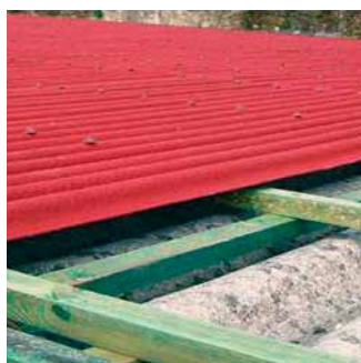
Instalación sobre cubierta existente
