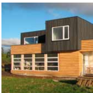
Instalación vertical como revestimiento
